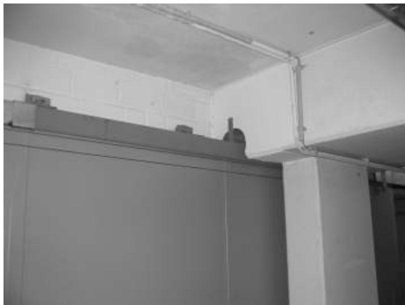
Feuerschutztor nach der Sanierungsmaßnahme
